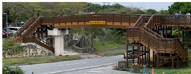
FRP 歩道橋 (沖縄県)
